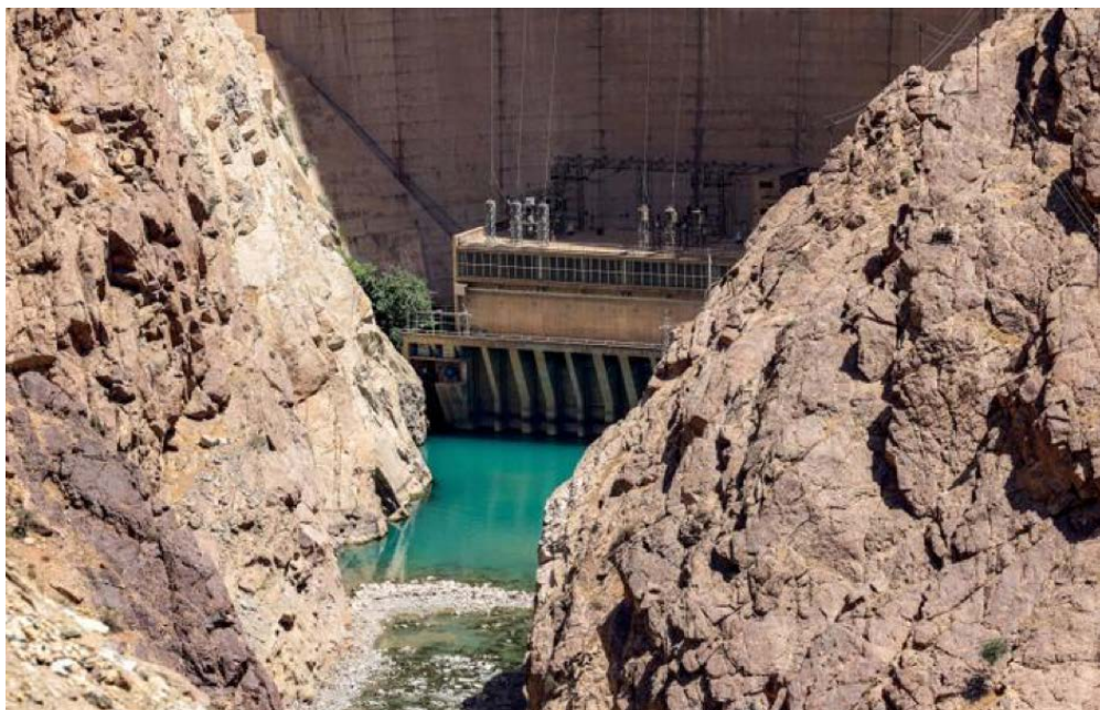
Les vannes de décharge du barrage de Karadj, dans la chaîne montagneuse de l'Elbourz, dans le nord de l'Iran, le 1 er juin 2025. ATTA KENARE/AFP
