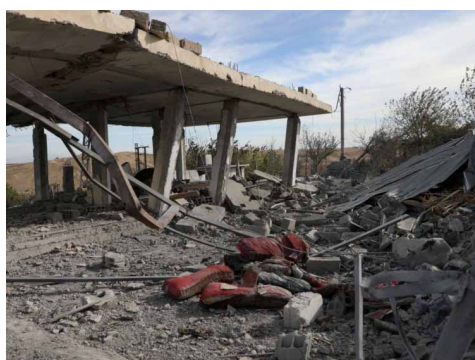
Un immeuble endommagé suite aux frappes aériennes turques, dans la campagne de Derik, en Syrie. /Photo prise le 21 novembre 2022/ REUTERS/Orhan Qereman
