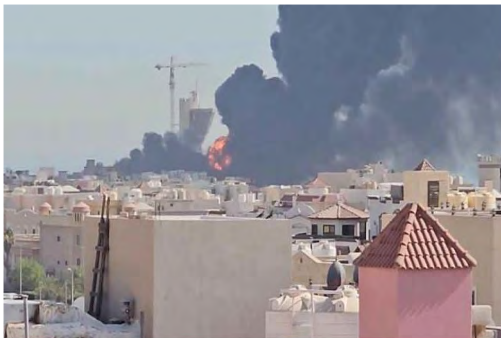
Capture d'écran extraite d'une vidéo diffusée sur les réseaux sociaux, montrant des panaches de fumée près d'une installation pétrolière à Mangaf (Koweït), le 18 juillet 2026. SOCIAL MEDIA VIA REUTERS
