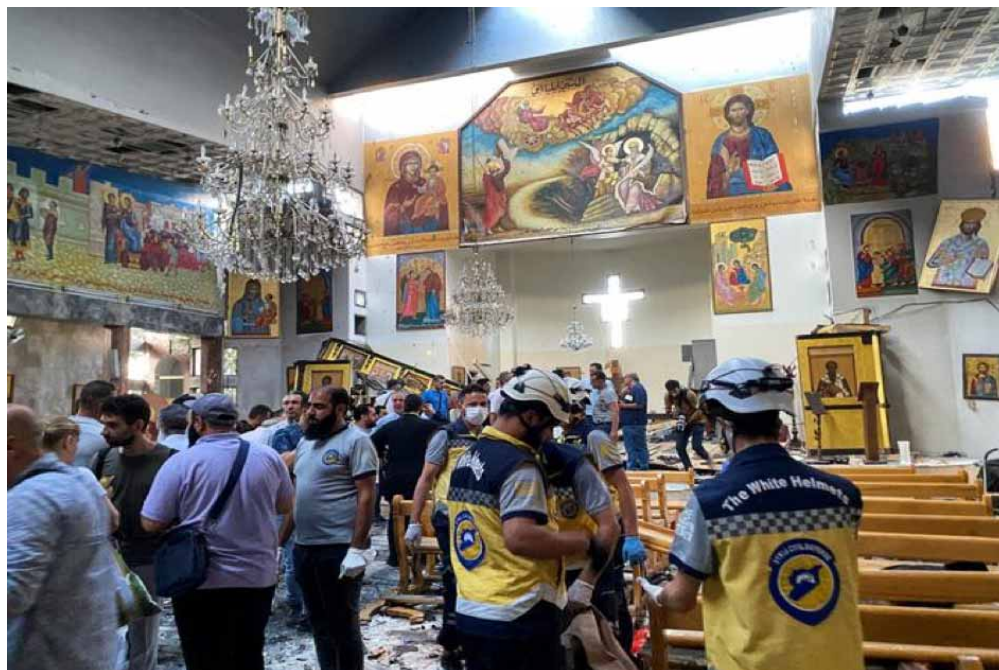
Des habitants et des membres de la défense civile inspectent les dégâts après une explosion dans l'église Saint-Elie, à Damas, le 22 juin 2025. FIRAS MAKDESI / REUTERS
