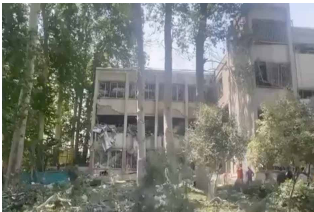
Un bâtiment administratif de la prison d'Evin, touché par une frappe israélienne, sur un extrait d'une vidéo diffusée sur le site de l'agence Tasnim News, proche du pouvoir iranien. VAHID ONLINE
