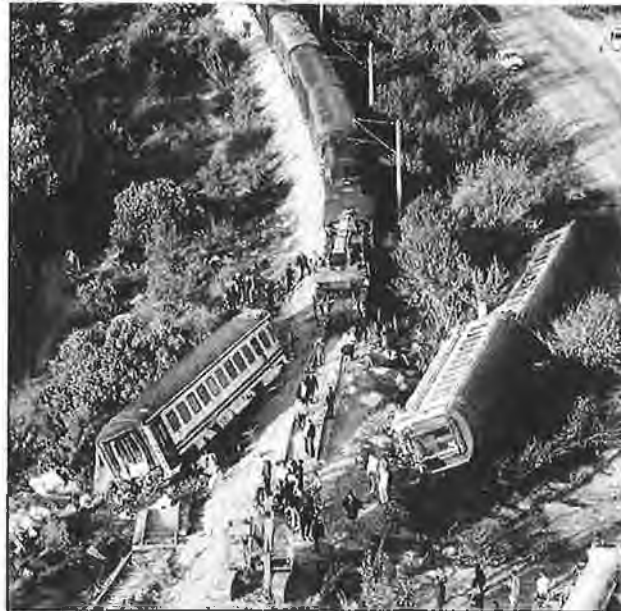
Après le déraillement du train Istanbul-Ankara, près de Pamukova dans le nord-ouest du pays, l'entretien des voies ferrées est sérieusement mis en cause. (Photo Hurriyet/AFP.)
